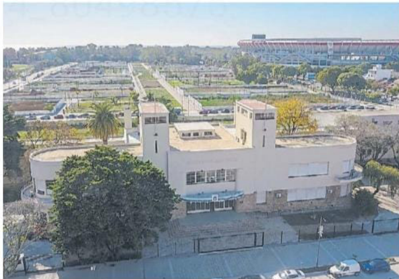
EX TIRO FEDERAL. La remodelación del predio donde este año se realizó Casa FOA.
