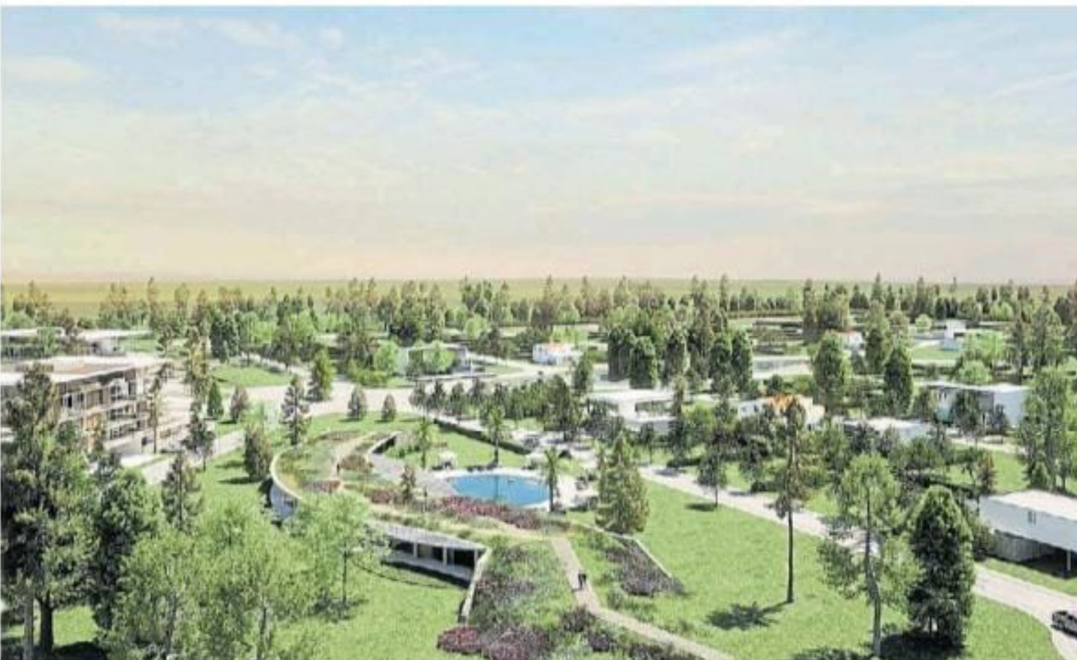
SUBURBANO. Cercana, en Canning, barrio privado desarrollado por el estudio Reñé Arquitectura.
