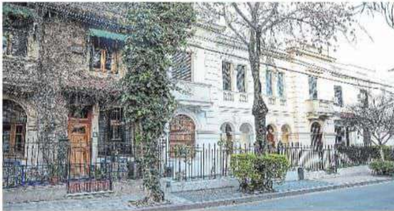
• INFLUENCIA INGLESA La tradicional calle Valle concentra la oferta de casas históricas
